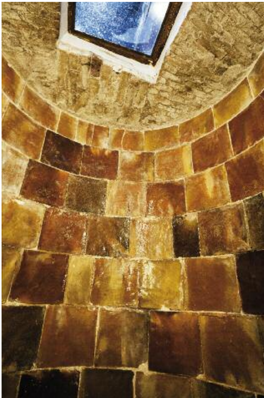
Tina del carrer de Sobrerroca, 38 (local del Via Fora).
